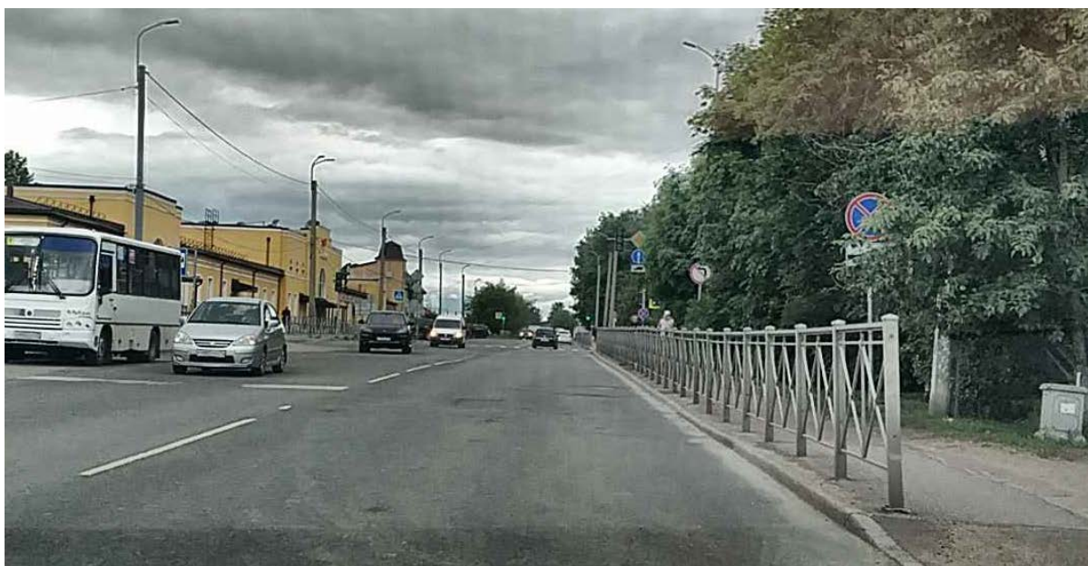
Рисунок 2.6.1.5 – Знак 3.27 «Остановка запрещена» и 8.24 «Работает эвакуатор» (по правой стороне дороги) находится за ветками деревьев, затруднен обзор (ул. Чехова)
