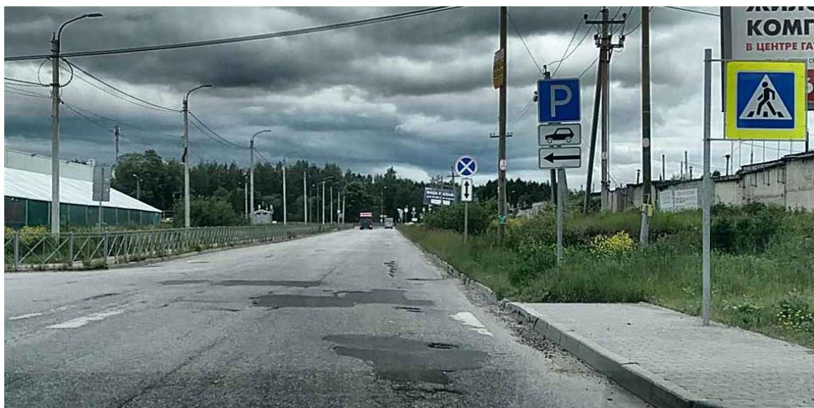
Рисунок 2.4.2.2 – Прерывание тротуара и отсутствие понижения бордюрного камня, ул. Крупская
