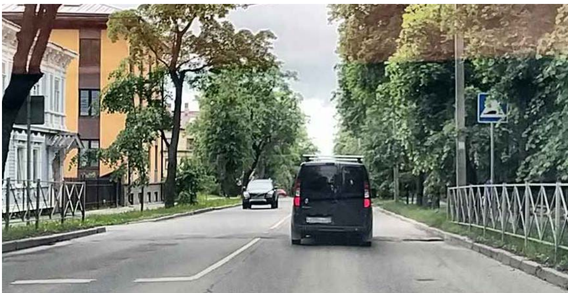
Рисунок 2.6.1.6 – Знак 5.22 «Искусственная неровность» (по правой стороне дороги) находится за ветками деревьев, затруднен обзор (ул. Чкалова)
