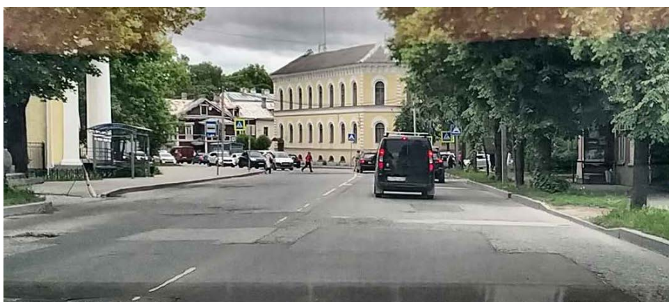
Рисунок 2.6.2.3 – Несоответствие разметки 1.6 требованиям п.5.1.15 ГОСТ 32953-2014, улица Чкалова
