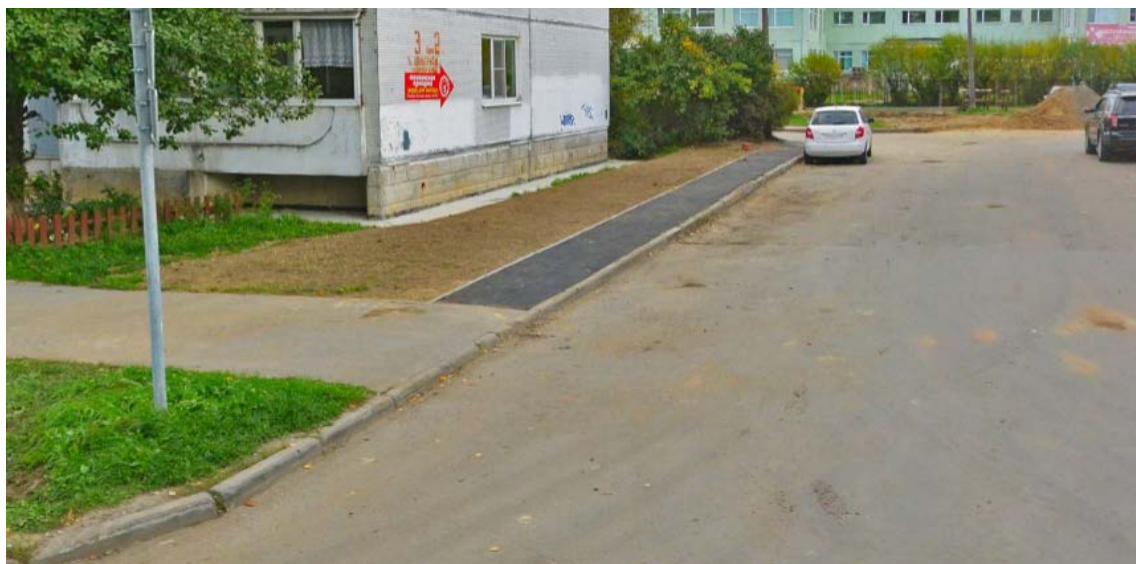
Рисунок 4.18.4 – Отсутствие занижения бордюрного камня у МФЦ Мои Документы отдел Аэродром Гатчинского района
