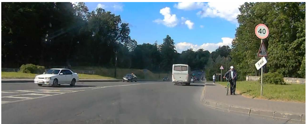
Рисунок 2.6.1.3 – Эксплуатационное состояние знака 3.24 «Ограничение максимальной скорости» не соответствует требованиям ГОСТ Р 50597-2017, проспект 25 Октября
