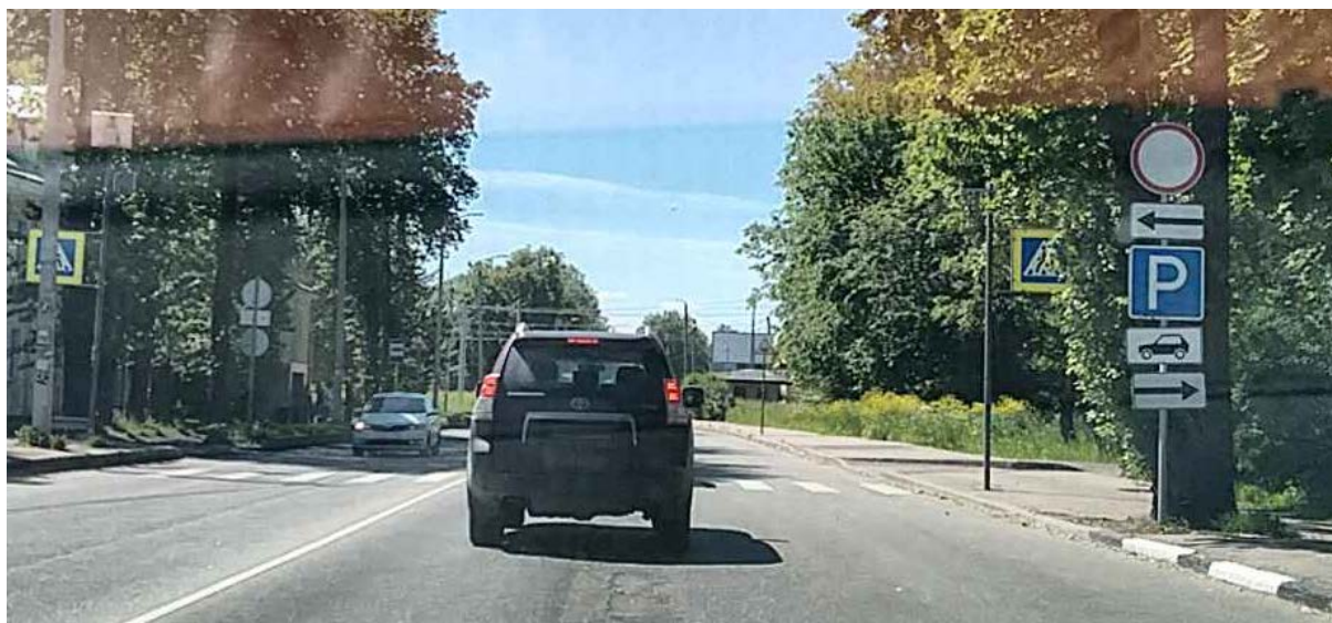
Рисунок 2.6.1.1 – Высота установки знаков не соответствует требованиям ГОСТ Р 52289-2019, проспект 25 Октября
