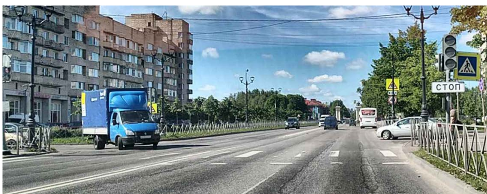
Рисунок 2.6.2.2 – Несоответствие разметки 1.1, 1.12, 1.14.1 требованиям п.5.1.15 ГОСТ 32953-2014, проспект 25 Октября
