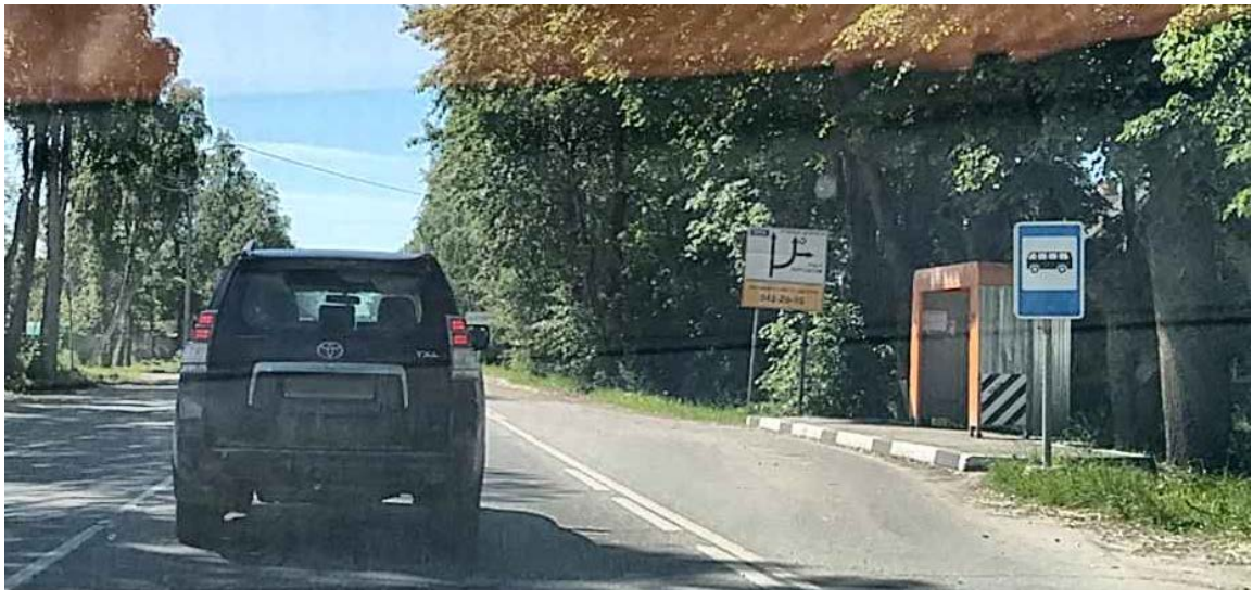
Рисунок 2.6.1.2 – Высота установки знака 5.16 «Место остановки автобуса и(или) троллейбуса» не соответствует требованиям ГОСТ Р 52289-2019, проспект 25 Октября
