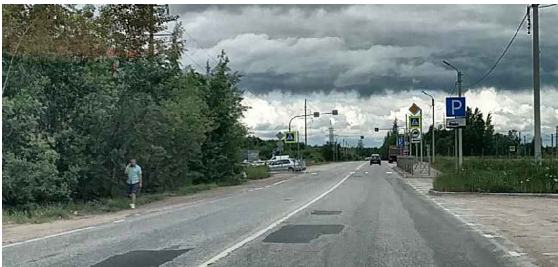
Рисунок 2.4.2.1 – Отсутствие тротуара (пешеходной дорожки), ул. Чехова
