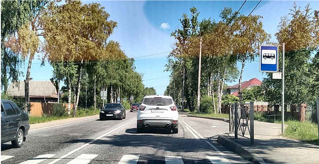
Рисунок 2.4.1.3 – Остановочный пункт «Школьный переулок» на ул. Киевская (отсутствует автопавильон, частично отсутствует дорожная разметка)
