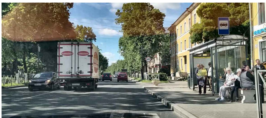
Рисунок 2.4.1.1 – Остановочный пункт «Кирха» на просп. 25 Октября (отсутствует дорожная разметка)
