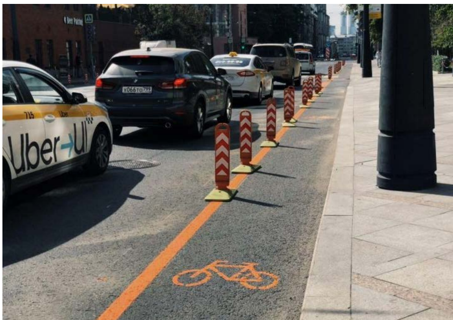
Рисунок 4.7.2.6 – Полоса для велосипедистов, отделенная делиниаторами в Москве.
