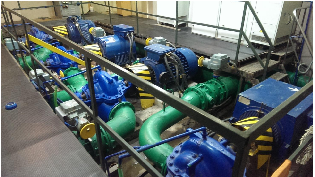
Рисунок 15 - Машзал насосной станции водозабора оз. «Серебряное»
