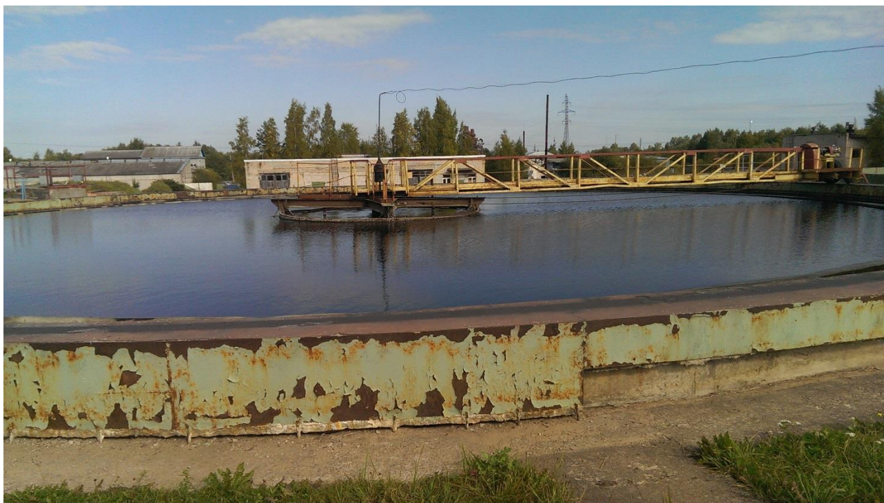
Рисунок 55 - Вторичный отстойник (в работе)
