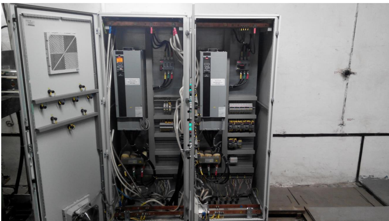
Рисунок 62 - Распредустройство РНС
