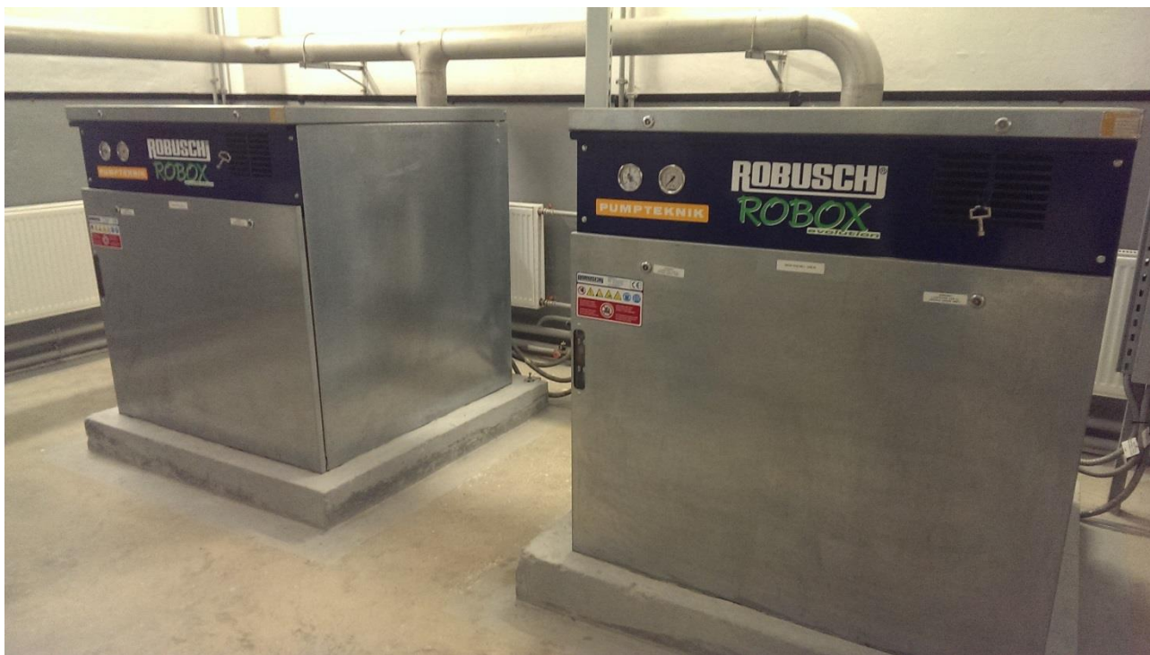
Рисунок 48 - Воздуходувки песколовок
