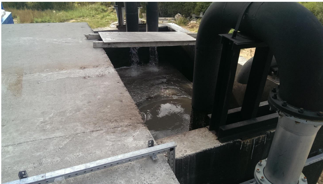
Рисунок 35 - Приемная камера КОС.
