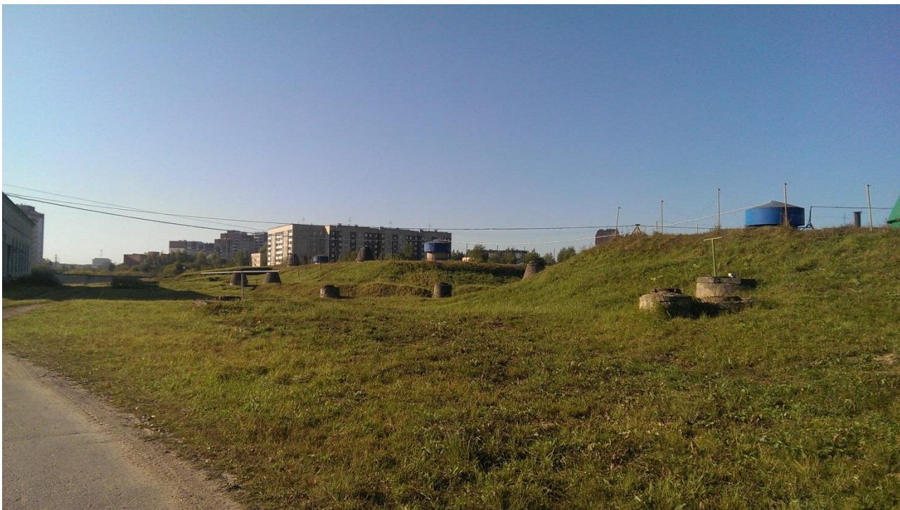
Рисунок 20 - Заглубленные резервуары сырой воды ВНС «Невская» (2 шт. по 10 тыс.м 3 )
