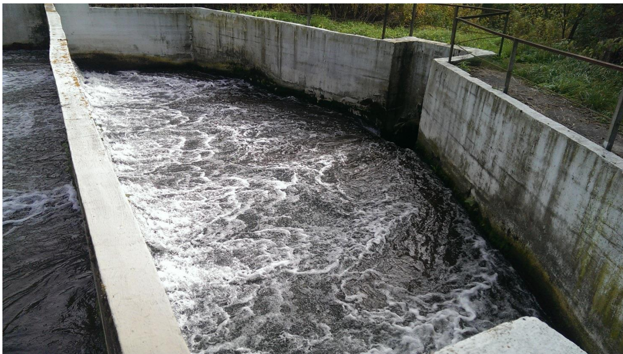
Рисунок 44 - Многоступенчатый водослив-аэратор
