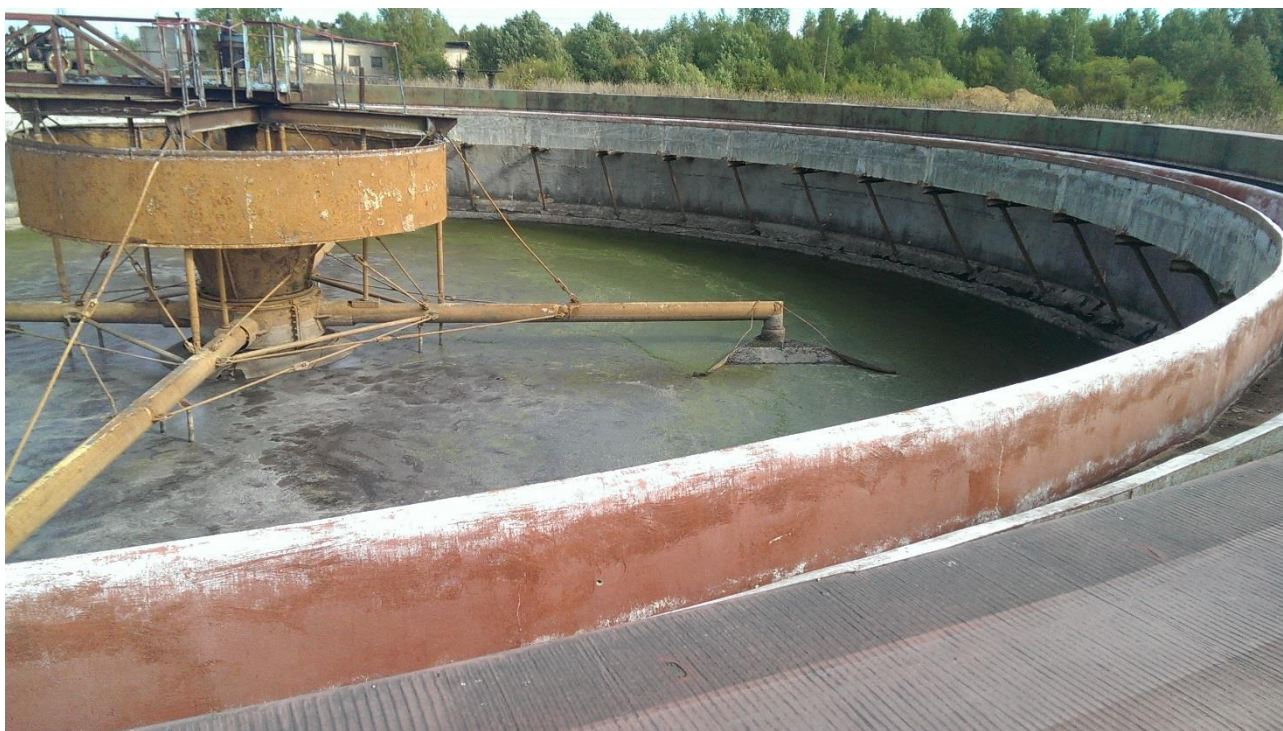
Рисунок 56 - Вторичный отстойник (опорожненный)
