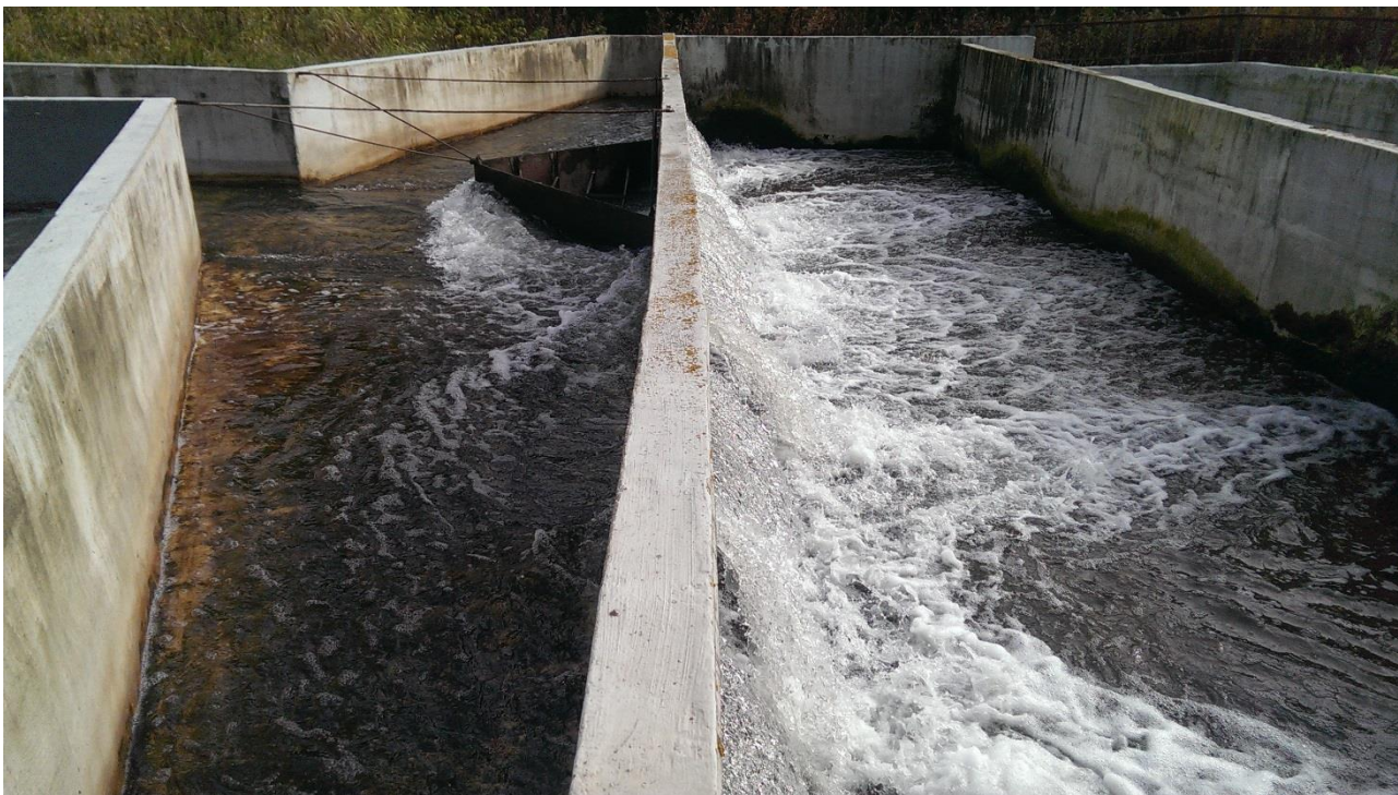
Рисунок 59 - Внешний вид перегородки водослива
