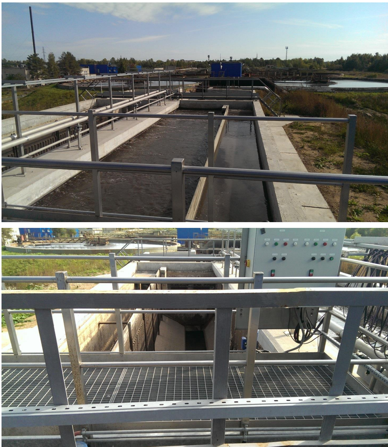
Рисунок 37 - Песколовки
