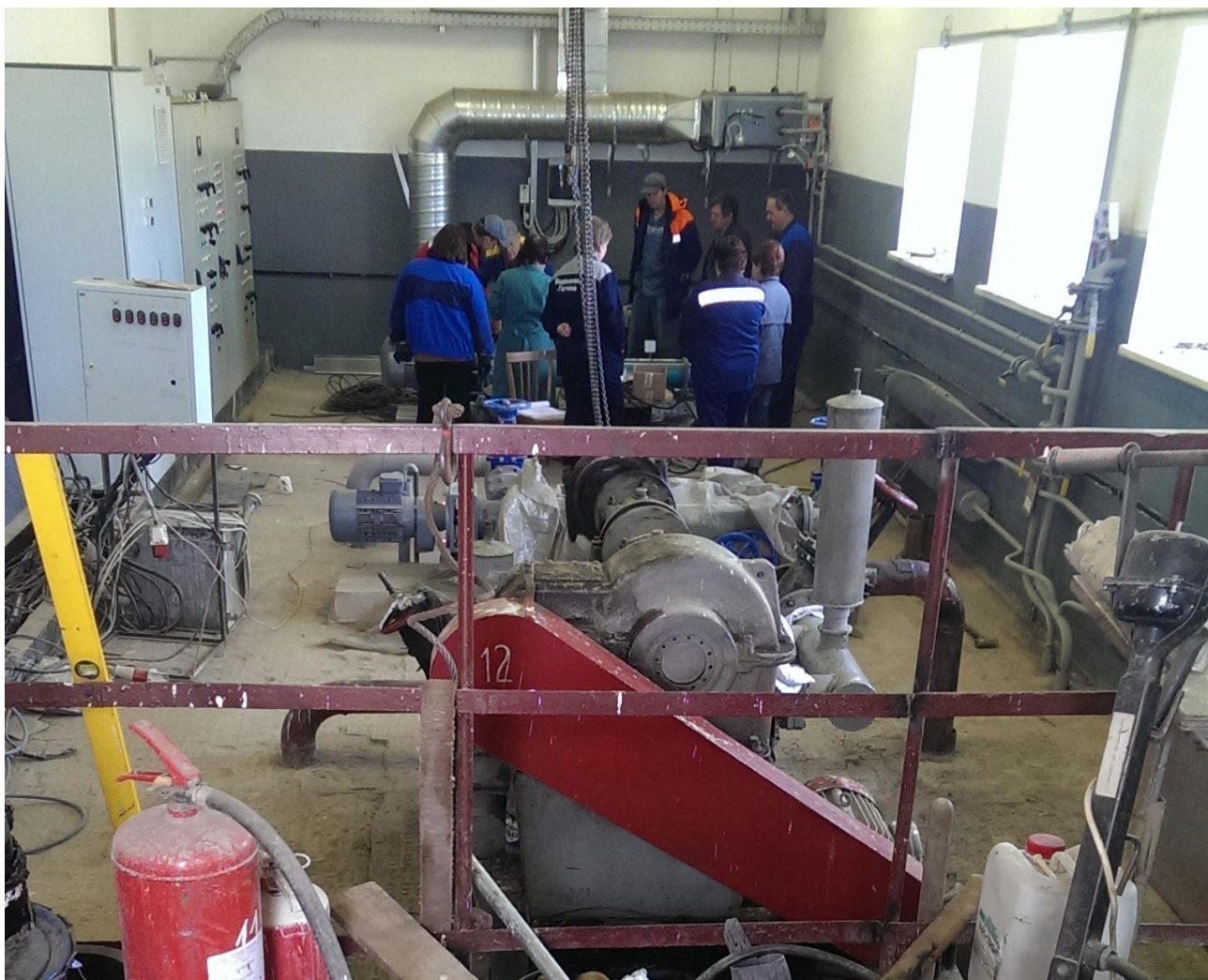
Рисунок 41 - Насосная станция сырого осадка со старым плунжерным насосом (ближний)
