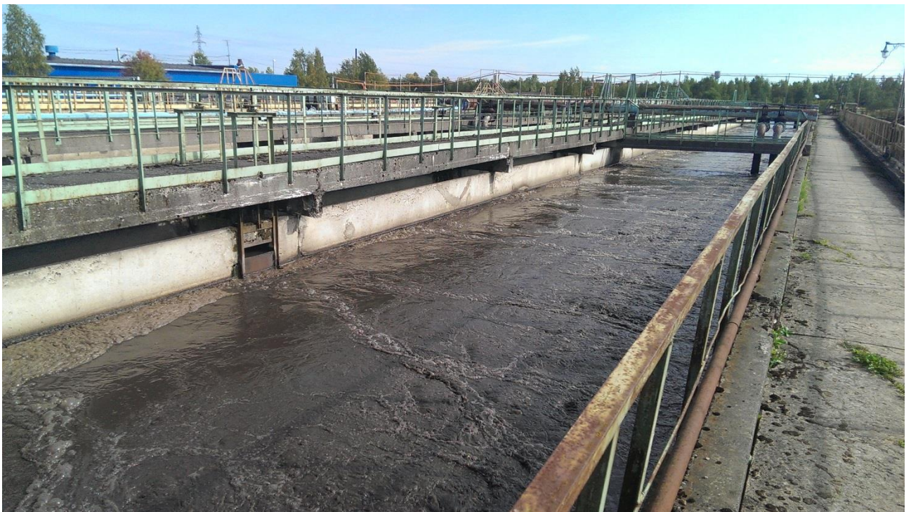
Рисунок 43 - Аэротенк
